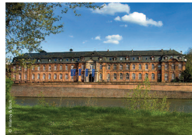
L'ancienne abbaye, siège de Villeroy & Boch à Mettlach
